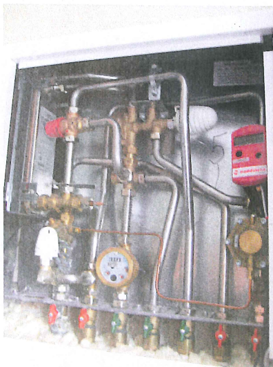
Die Unterputzschränke der Wohnungsübergabestationen befinden sich im Stiegenhaus. Dadurch ist für die Anlagenbetreiber jederzeit ungehinderter Zugang möglich (im Bild li.: Herz-Wohnungsübergabestation „Standard“).
