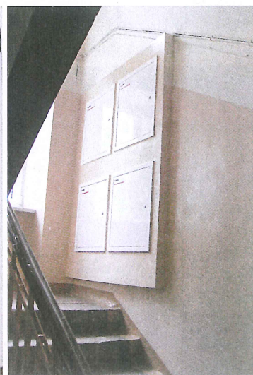
Die Unterputzschränke der Wohnungsübergabestationen befinden sich im Stiegenhaus. Dadurch ist für die Anlagenbetreiber jederzeit ungehinderter Zugang möglich (im Bild li.: Herz-Wohnungsübergabestation „Standard“).
